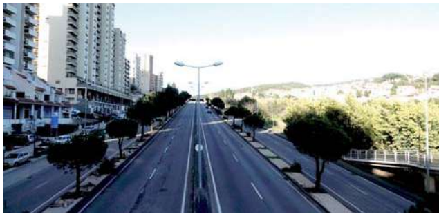
Processo será concluído com a repavimentação das áreas interveniçionadas e a renovação da sinalização horizontal
