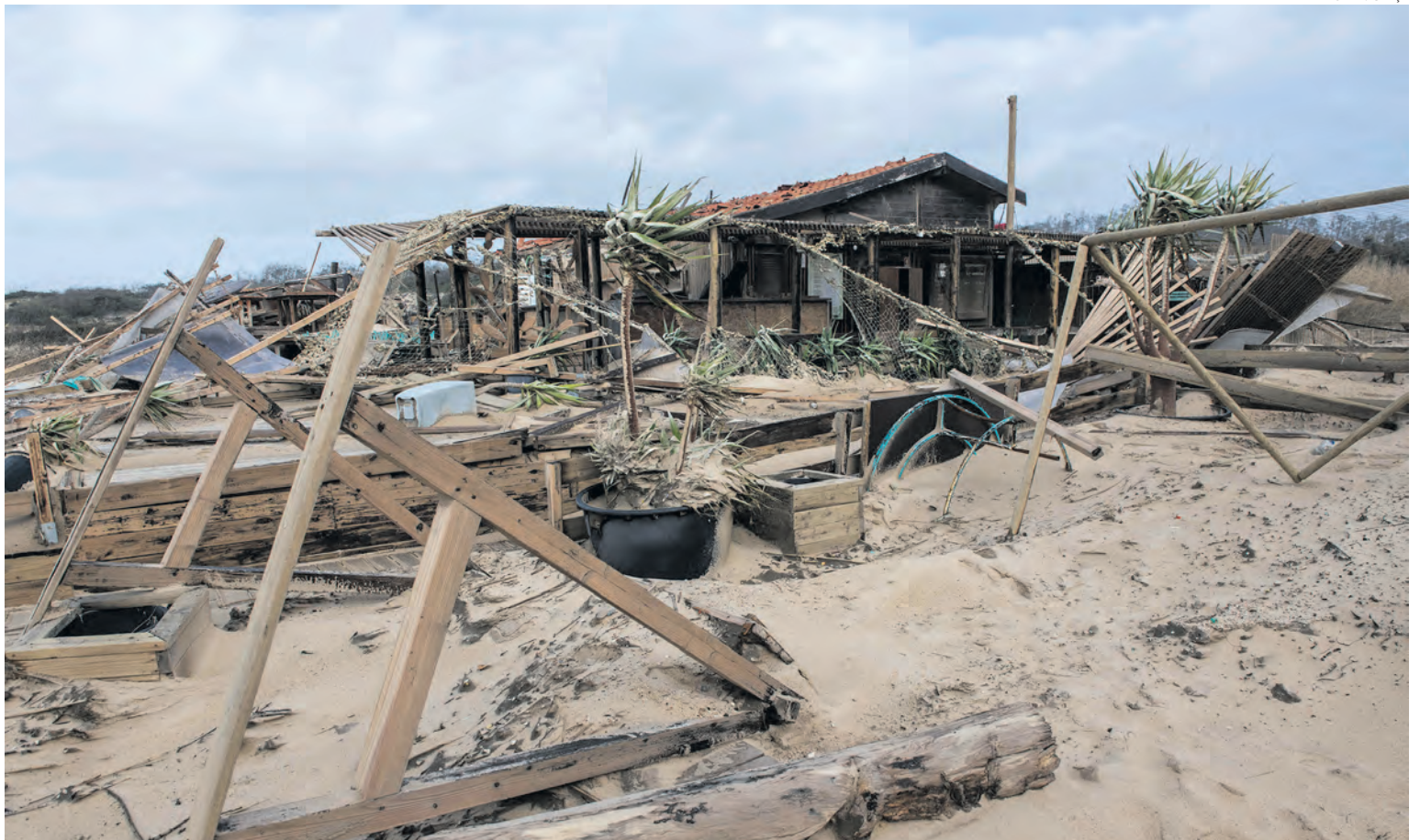
Old Beach voltou a conhecer a destruição e será recuperado a tempo da época balnear
